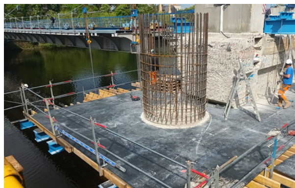
Photo prise sur le chantier le 04/05/2023
