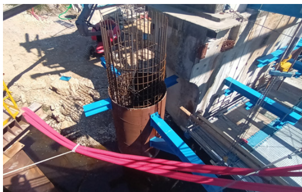
Photo prise sur le chantier le 20/04/2023
