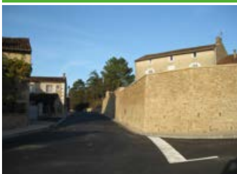
APRÈS LES TRAVAUX
