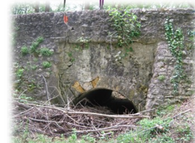
Pont n°3 : 1 arche
