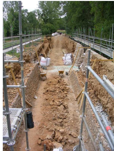
Pont n°3 et soutènement
