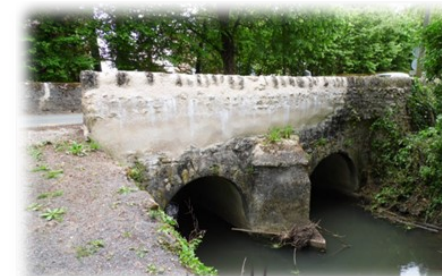
Pont n°1 : 2 arches
