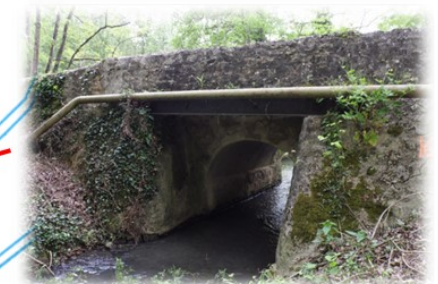
Pont n°4 : 1 arche
