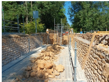
Mur de soutènement du pont n°3
