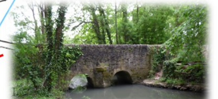
Pont n°2 : 2 arches
