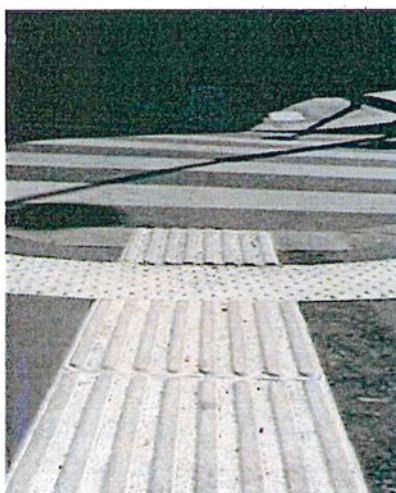
BAO Parisign installée de part et d'autre de la BEV
