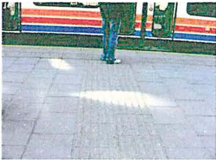
UK, accès au quai du tramway
