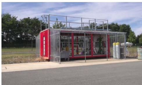
✓ Un plateau technique "gaz/électricité"
