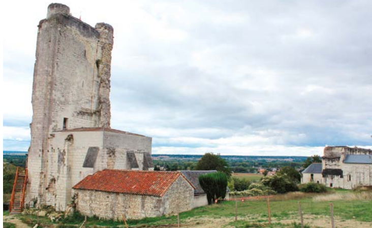
> Le Château du Haut-Clairvaux à Scorbé-Clairvaux.
