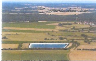
Réserve existante à Château Larcher
