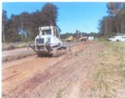
Travaux de décapage
