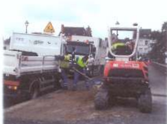
Pont Henri IV – Réalisation de sondages pour le service Ouvrages d'Art
