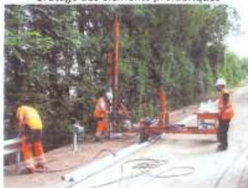
Battage des glissières de sécurité
