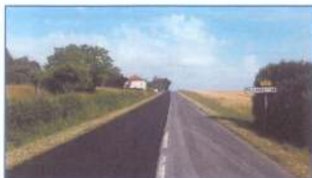
Revêtement en ECF (Enrobés Coulés à Froid) RD8 - 5 km entre Bouresse et Verrières, RD 121, 5 km entre Journet et la Trimouille
