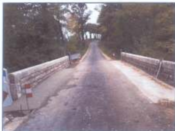
RD 112a – travaux d'étanchéité des trottoirs d'un ouvrage d'art
