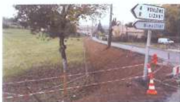
RD 103 – RD 104 – Confection d'un talus – Commune de Saint-Macoux
