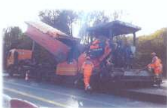
Réalisation des couches en grave bitume
