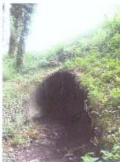
Buse avant travaux
