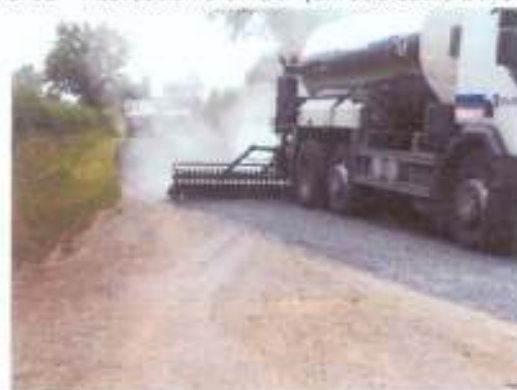
RD 27 – Réalisation d'un enduit gravillonné
