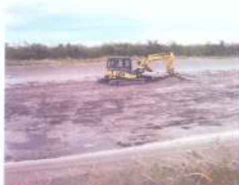
Enlèvement des boues
