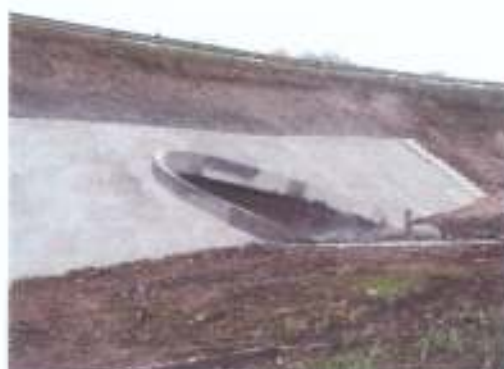
Buse côté amont après travaux
