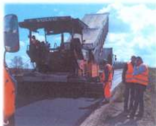
RD 42 – Travaux d'enrobés suite aux opérations LGV
