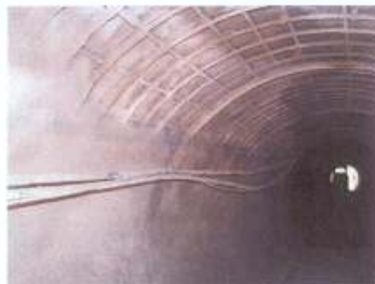
Coque en béton projeté
