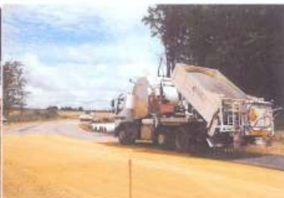
Enduit de cure sur traitement ciment
