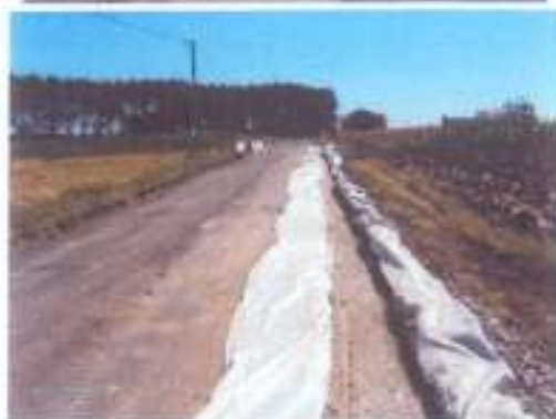
RD 148 – Chantier de reprofilage généralisé sur 1 km – Commune de Roiffé « Le Pontigniaux »
