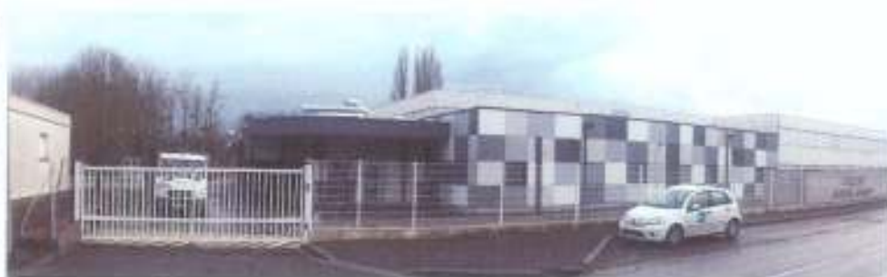
Réhabilitation de la demi-pension du collège de Lençloître
