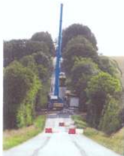
Grutage des éléments préfabriqués
