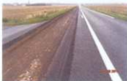
RD 61 – Route de Richelieu – Chantier de purges profondes sur 0,23m à 1m pour un montant de travaux de 300 000 €
