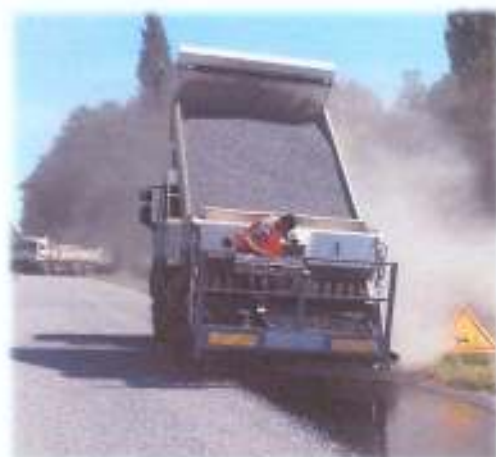
RD 14 – Enduits superficiels
