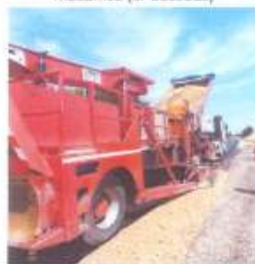
RD 611 – Travaux de renforcement avec mise en place de la signalisation de chantier (ci-dessus) et le calage d'accotement mécanisé (ci-dessous)
