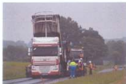
RD 741 – Travaux d'enrobés – Communes de Gençay et Brion
