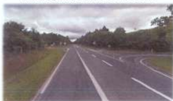
Tourne à gauche existant - Avant travaux
