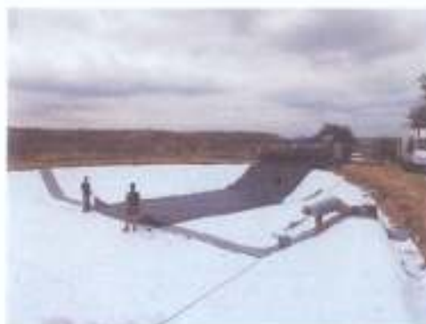
Pose de nappe drainante
