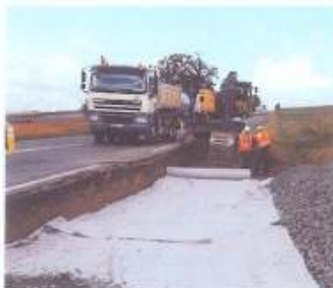
Création des poutres sur la RD 347
