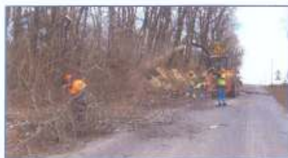
RD 118 – Chantier d'élagage grande hauteur
