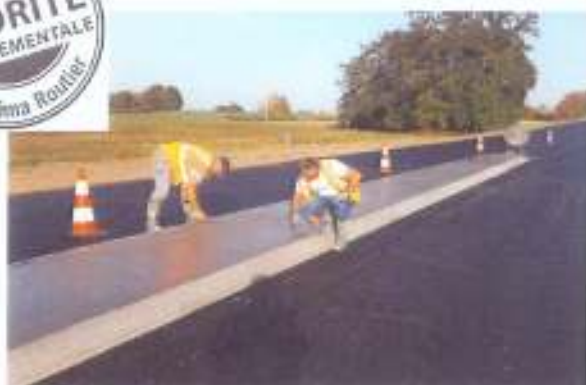
Réalisation des îlots sur la RD 347
