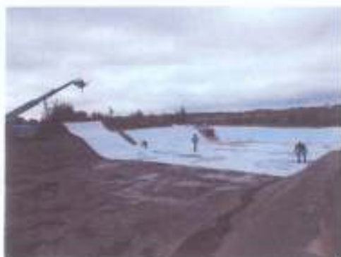
Pose d'un géotextile
