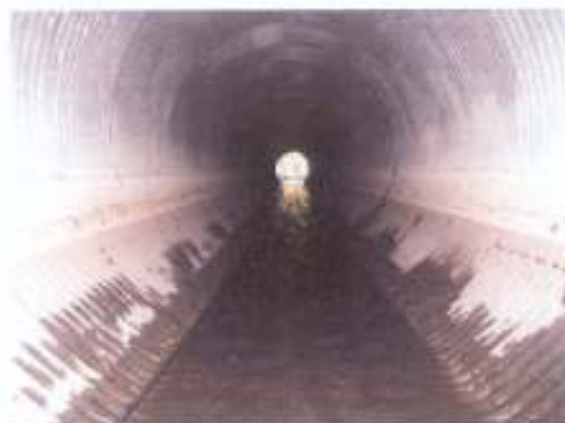
Intérieur de la buse après nettoyage
