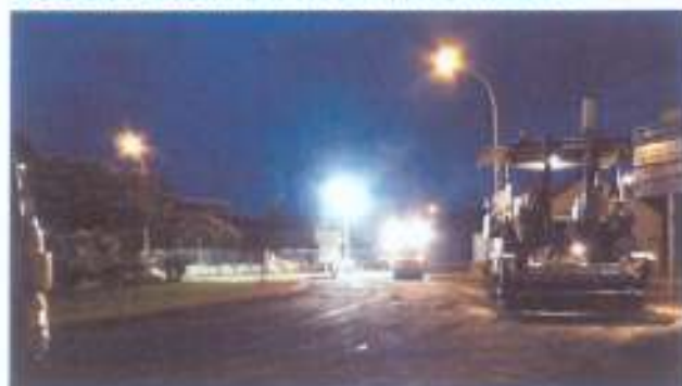
Carrefour RD 951 /RD 749 : Réfection de giratoire – Travaux de nuit – commune de Chauvigny
