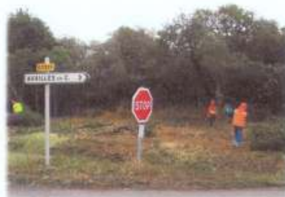
Défrichage des espaces boisés et pose de clôtures en régie
