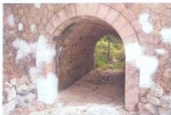
RD 28 – Pont de la Palisse – Commune de Millac
