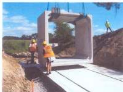
Mise en œuvre des éléments préfabriqués
