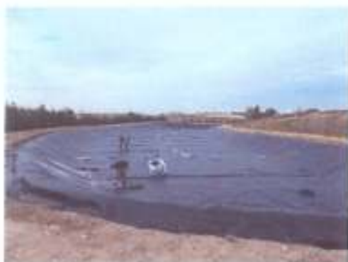
Pose d'une nouvelle bâche
