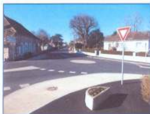
Réfection de la RD 121b et aménagement du carrefour RD 675/RD 121b- Commune de La Trimouille.
