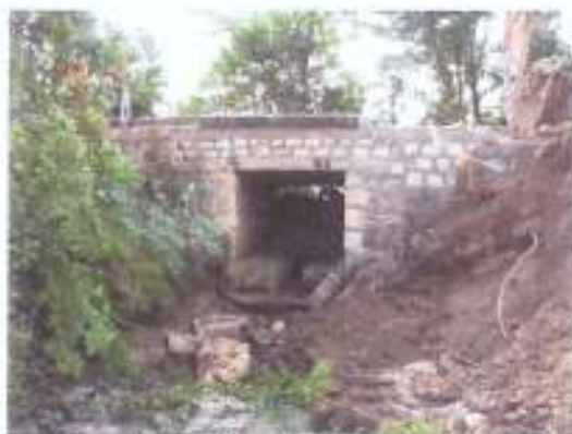
Démolition de l'ouvrage
