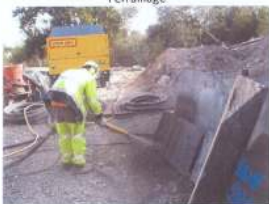
Essai de convenance du béton projeté
