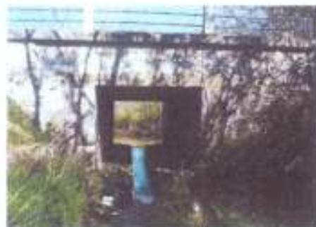
Pont avant travaux
