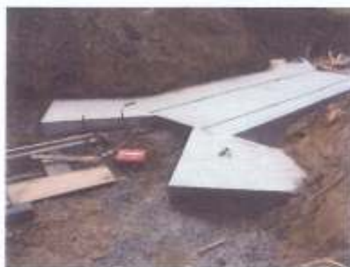
Dalle support de l'ouvrage
