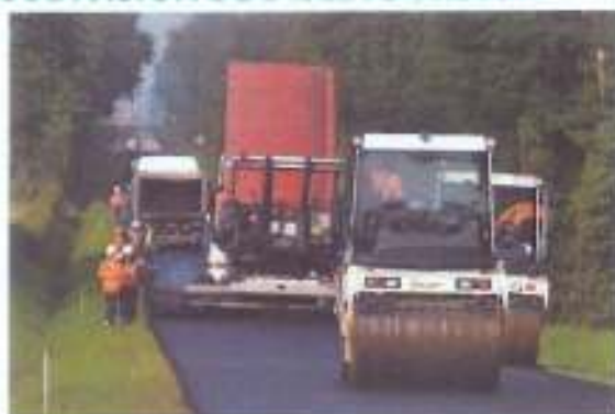
RD 10 - Réfection de chaussée – Commune du Vigeant
