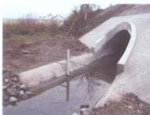
Buse côté amont après travaux
