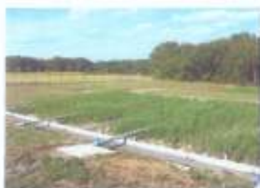
Traitement des eaux usées par filtres plantés de roseaux
