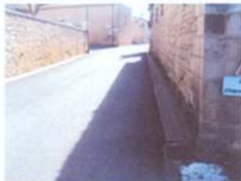
RD 47 – Loudun – Vesniers -Traverse d'agglomération pour un montant de travaux de 45 000 €
