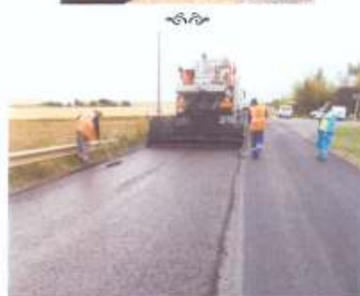
RD 62 – Réalisation d'un ECF (enrobé Coulé à Froid)
