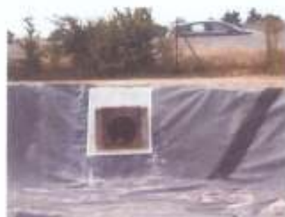
Etanchéité autour des ouvrages
