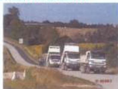
RD 759 – Chantier de purges avec mise en œuvre d'un revêtement type chape épaisse sur 11 km de Loudun à Beuxes
