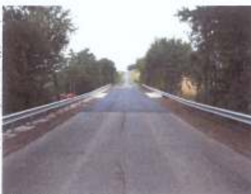
Chaussée après travaux
