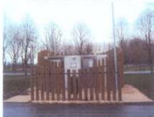
RD 347 Chalais : construction d'un bloc sanitaire automatique sur l'aire de repos « La Briande » Travaux de déconstruction et VRD : 45 000€ Installation de la cabine : 50 000€
