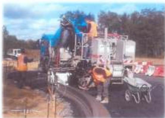
Réalisation des bordures béton coulées en place
