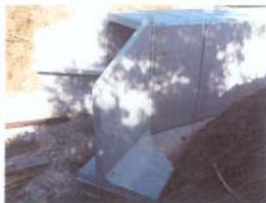
Mise en œuvre des murs en ailes (avec passage à faune)
