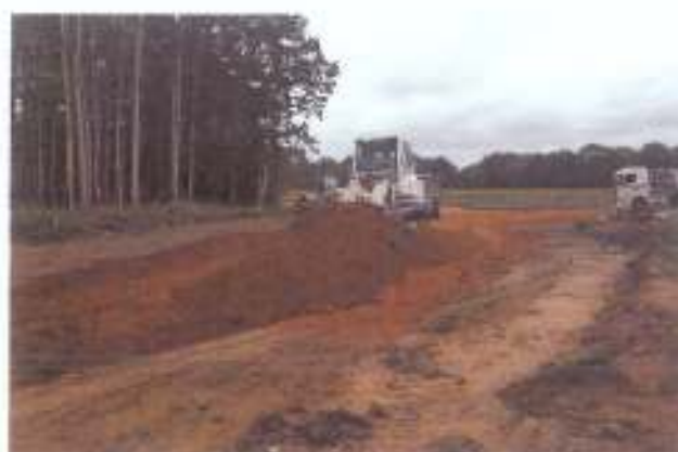
Mise en oeuvre des matériaux avant traitement
