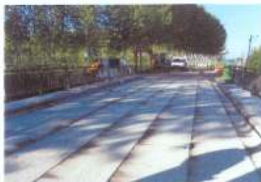
RD 39 – Travaux de reprise du tablier du pont de la Charrière sur la commune de Curçay sur Dive (fermeture de la RD pendant 3 mois)
