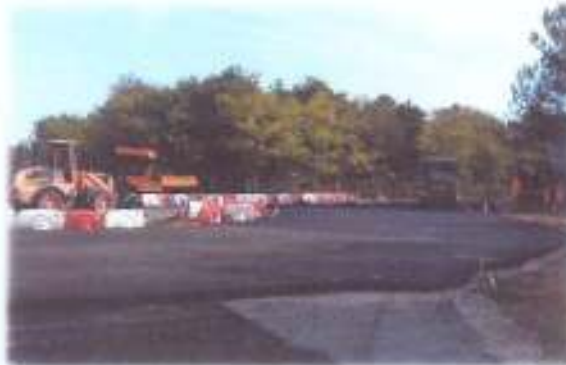
Réalisation des couches en grave bitume
