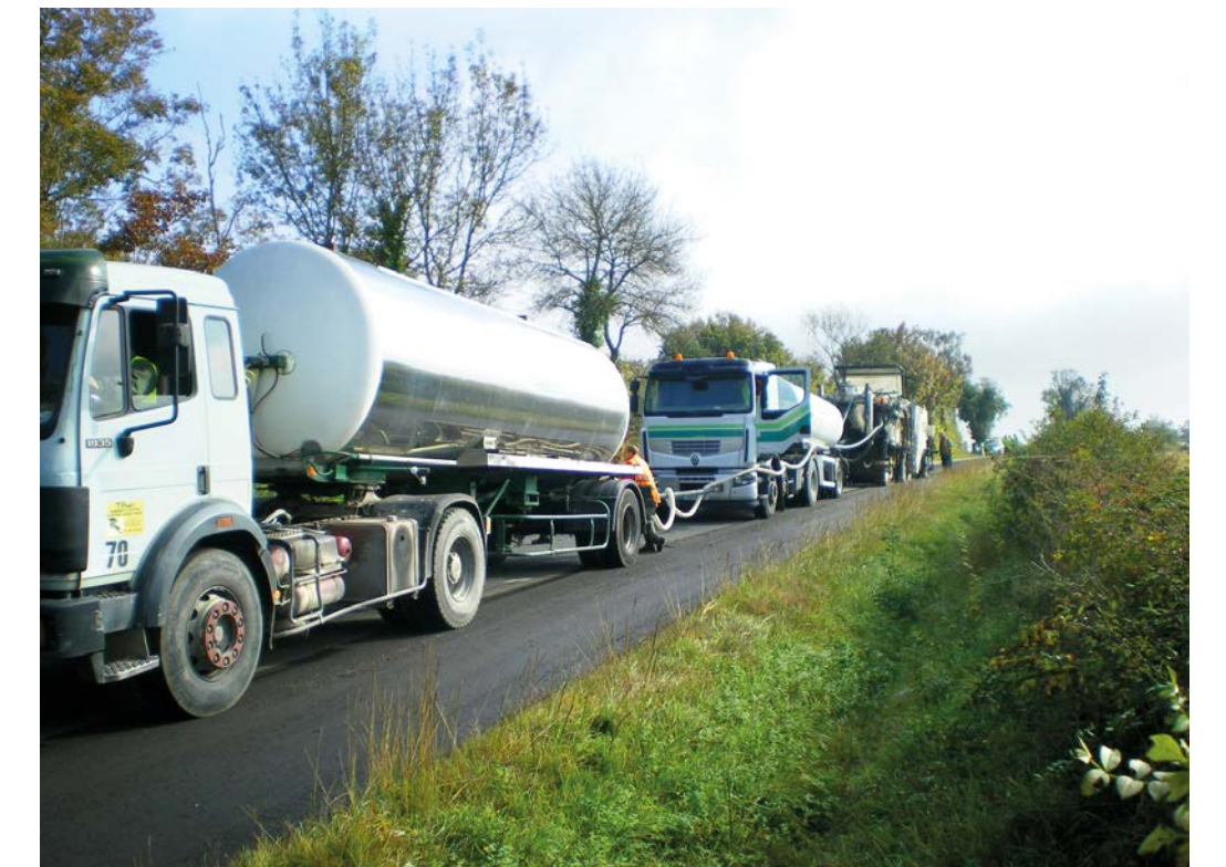
Chantier routier à fort taux de recyclage
