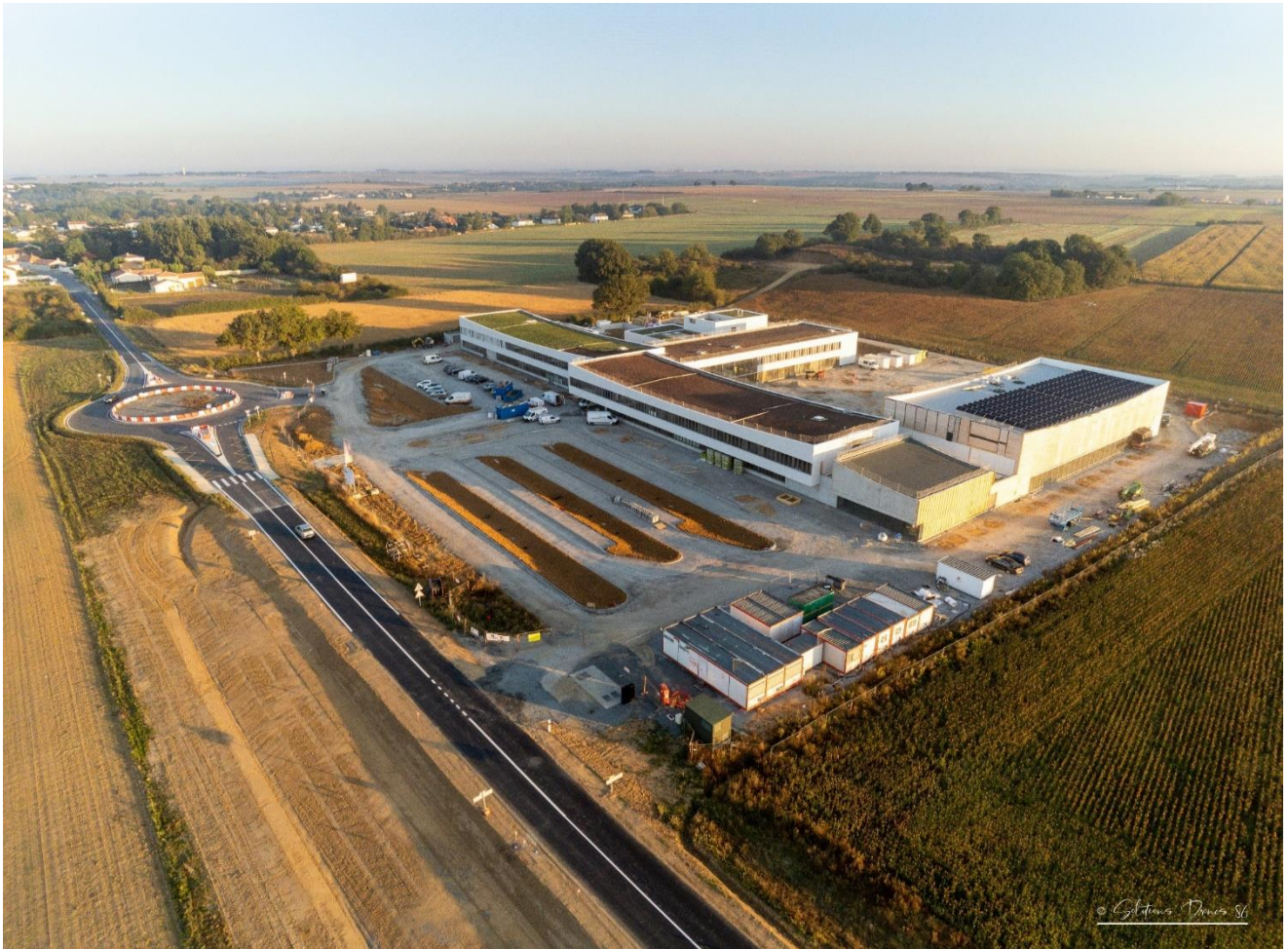
Panneaux photovoltaïques et aménagements du collège Joséphine Baker à Vouneuil-Sous-Biard performant en environnement
