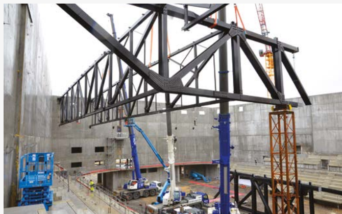
> 100 tonnes et 60 m de long pour la plus grosse poutre du chantier, posée début février.
