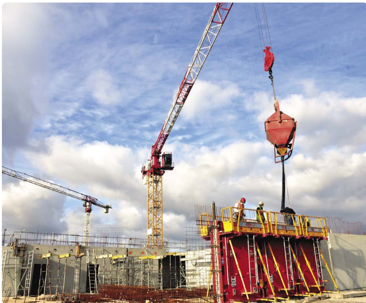
> Chantier du 35 e collège de Vouneuil-sous-Biard.
